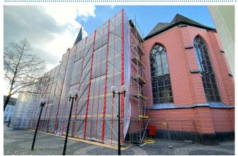
Das Bild eines Baugerüstes an St. Marien ist schon seit einigen Jahren vertraut. Nun haben die Arbeiten am fünften Bauabschnitt begonnen. In bewährter Art werden nun am nächsten Abschnitt an der Südseite (zur Burse hin) die obere Dichtungsschicht der Fassade, die sogenannte Schlämme, abgestrahlt und der darunter liegende Tuffstein im Anschluss mit einer neuen Schutzschicht versehen. Nach Ostern hat die Firma Nüthen mit den Arbeiten begonnen.
